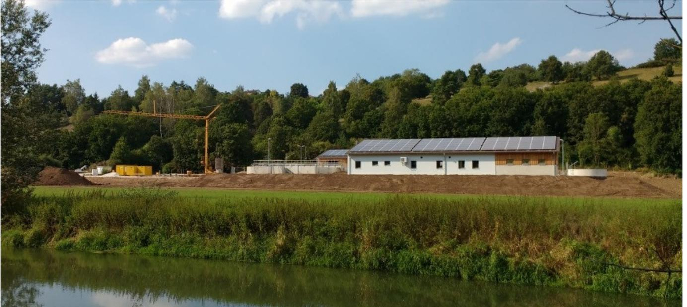
Die neue Kläranlage ist in Betrieb. Der Neubau ist weiterhin im zeitlichen und finanziellen Plan. Das Betriebsgebäude ist fertiggestellt und die Photovoltaikanlage (PV) installiert. Sie liefert bereits den Strom für den Betrieb. Die Arbeiten für die sanitären und elektrischen Einrichtungen sind abgeschlossen.
