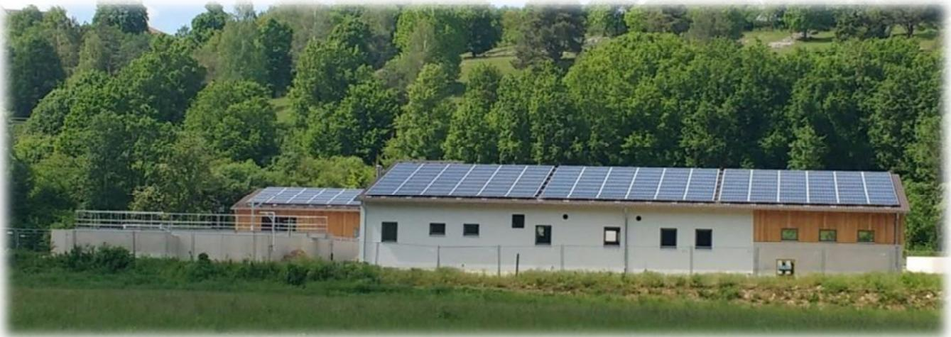
Der Kläranlagenneubau ist weiterhin im Zeitplan. Das Betriebsgebäude ist innen und außen verputzt, das Dach ist gedeckt und die Photovoltaikanlage (PV) installiert. Die Arbeiten für die sanitären und elektrischen Einrichtungen sind im Gange.
