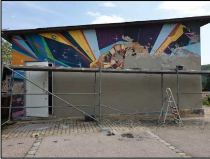
Bild 1 - Entfernen des alten Putzes
